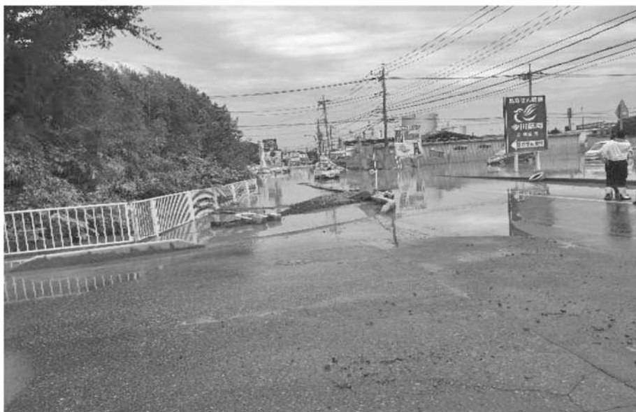
きぬ医師会前道路の冠水
